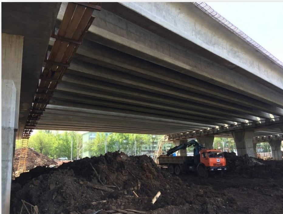
Сейчас на объекте идет монтаж пролётных строений: из 288 балок смонтировано уже 187. Каждая балка имеет вес порядка 30 тонн, везут ее с ЦБЗ в с.Зелёновка, на приёмке каждое изделие проходит строгий контроль качества, прежде чем транспортироваться на стройплощадку.
