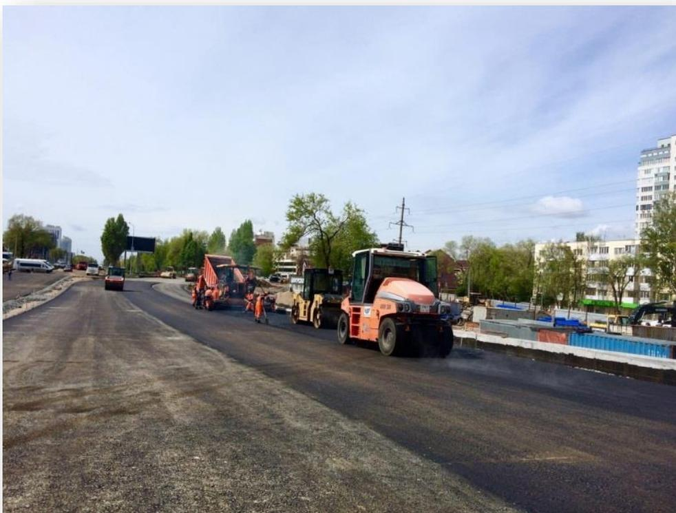
Эту работу проводили друг за другом цепочкой из 4-х машин: КАМАЗа с АБС, асфальтоукладчика и катков на пневмошинах и с гладким валом.
